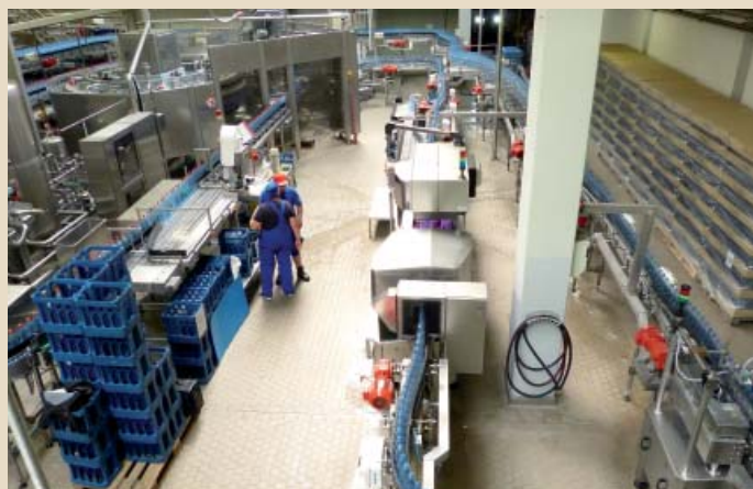
An der GDB-PET-Mehrweglinie werden dank der neuen Inspektionssysteme alle Flaschen mit Fehler ausgeleitet
